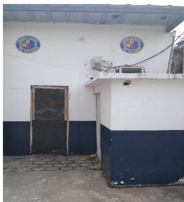
Registro levantamiento de infraestructura 2020
