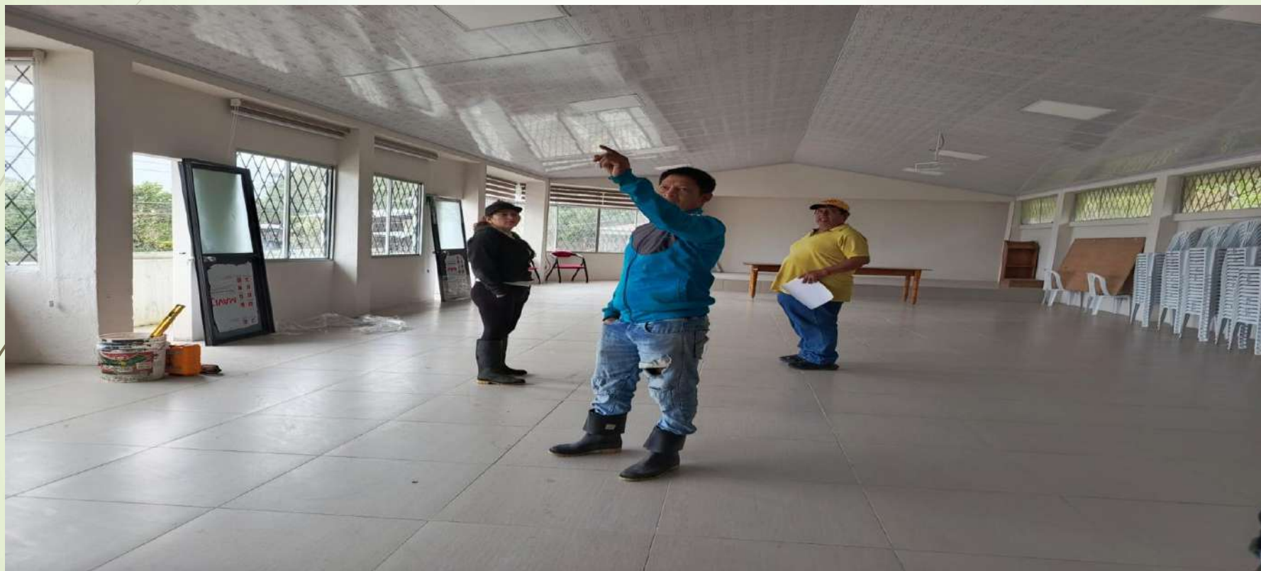
Fiscalización y observaciones en la obra del salón auditorio
